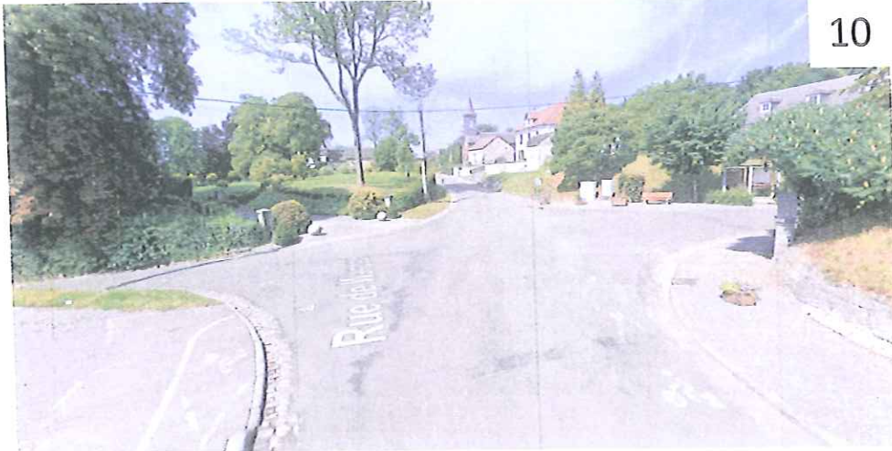
Carrefour Rue de Wanzoul, Rue Leon de Verlaine et Rue du Pousseron
